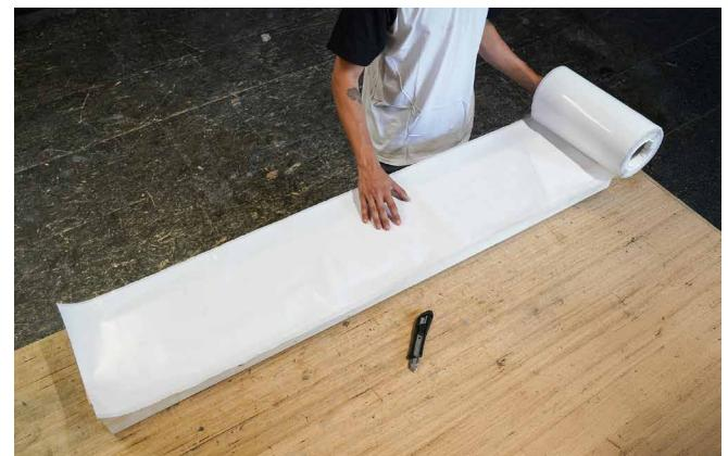
Posicionar corretamente a membrana sobre a superfície, verificando o alinhamento e a cobertura da área a tratar antes da colagem.
